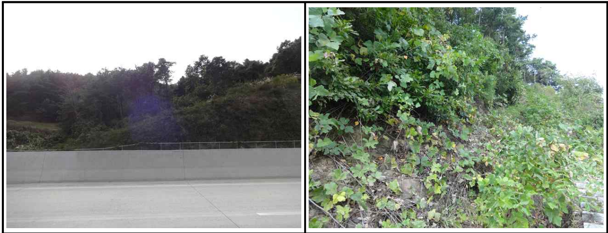
【그림 28.3.1】 상부자연사면 전경
