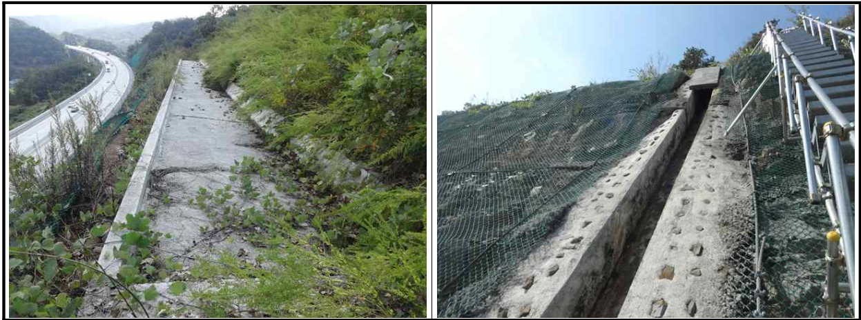
【그림 28.3.3】 배수시설 전경
